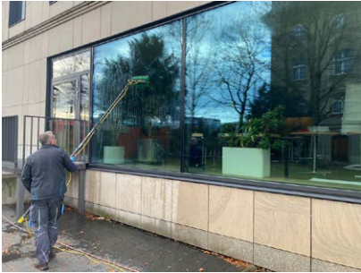
Fassadenreinigung mit Reinwasser
